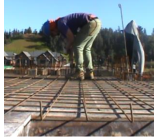
Figura 4. Instalación de malla de barras de fierro en la losa del primer piso
