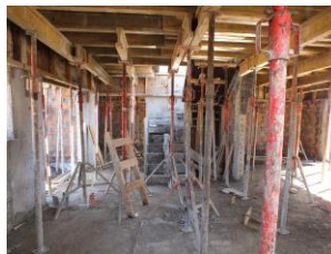
Figura 3. Moldajes sostenidos por vigas de madera y alzaprimas
