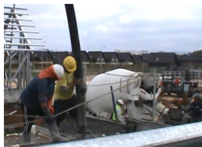
Figura 11. Vertido de hormigón mediante bomba y brazo telescópico en losa del primer piso.
