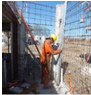
Figura 8. Instalación de moldajes de aluminio en la construcción de muros
