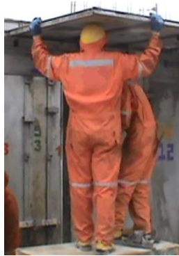
Figura 9. Instalación de moldajes en losa primer piso
