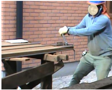
Figura 14. Tarea de doblado de fierros mediante grifa
