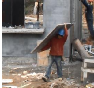
Figura 7. Transporte manual de moldajes
