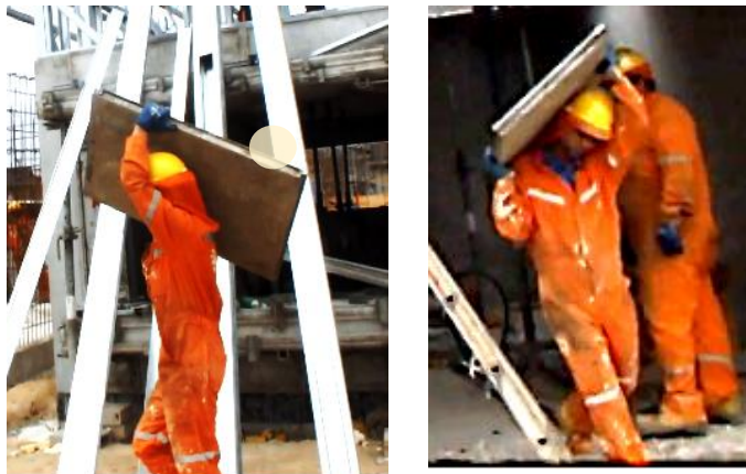
Figura 22. Imágenes que ilustran el transporte de moldajes
