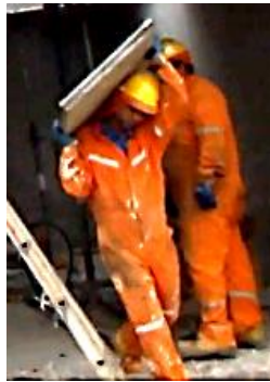
Figura 12. Transporte manual de moldajes de aluminio.
