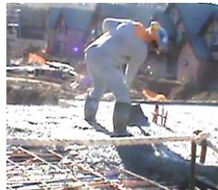
Figura 5. Paleado de hormigón en la losa del primer piso.
