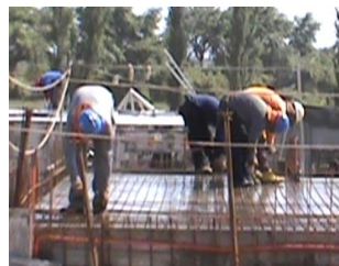
Figura 10. Armado de mallas de fierros en losa primer piso.
